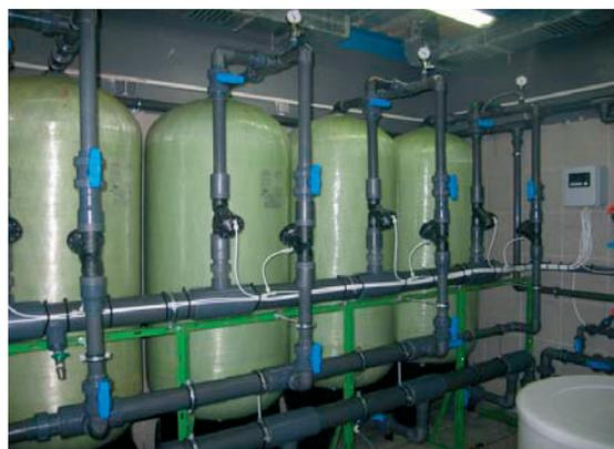
Схема предусматривает полное прекращение подачи воды потребителю во время проведения регенерации (в случае использования трех корпусов), либо ее ограничение (при использовании четырех корпусов и более).
