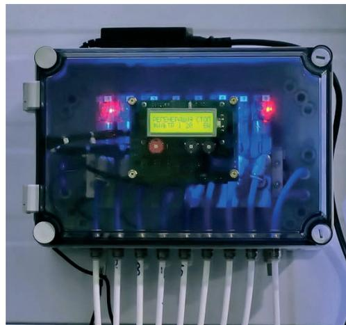
Конструктивную основу исполнительный части контроллера составляет блок пневмораспределителей, по одному пневмораспределителю на каждую линию управления. Для управления запорной арматурой с электрическим приводом вместо пневмораспределителей используются электромагнитные реле. За счет этого каждая линия управления является независимой, последовательность их переключения определяется выбранной технологической схемой и не имеет ограничений.
