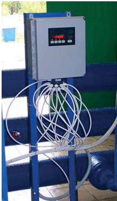
Контроллеры сочетают в себе стейджер (управляющий клапан) **AQUAMATIC** и блока управления **Autotrol 962** или **Fleck NXT**, смонтированные в едином корпусе. Продолжительность каждого цикла подлежит легкой настройке, что позволяет использовать их в соответствии с конкретным заданием в обширном диапазоне измерений.
